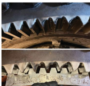
FIGURA 5: DESGASTES ENGRENAGEM PITCH BEARING
