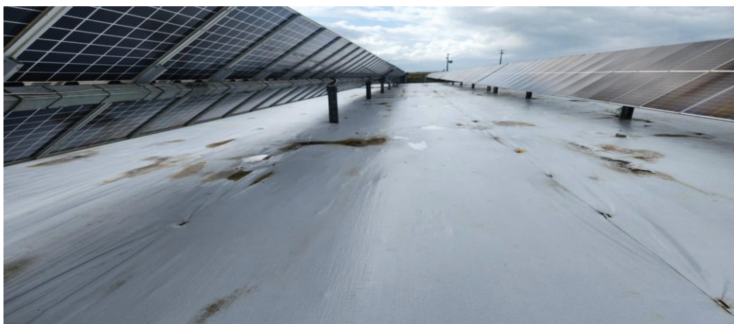
FIGURA 17 - PONTOS DE SUJIDADE NAS MANTAS REFLEXIVAS
