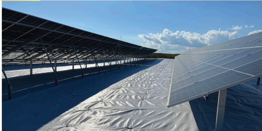
FIGURA 10 - APLICAÇÃO DE MANTAS REFLEXIVAS EM SISTEMAS FOTOVOLTAICOS
