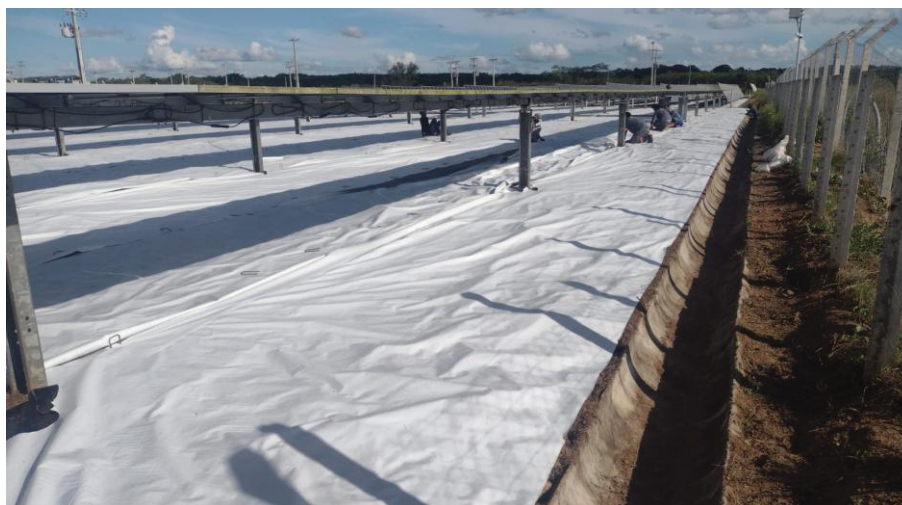
FIGURA 15 - TERRENO COM MANTA REFLEXIVA EM TODA EXTENSÃO (CENÁRIO 2)
