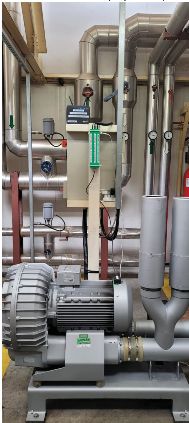
FIGURA 24 – Vista Geral aplicação em Campo
