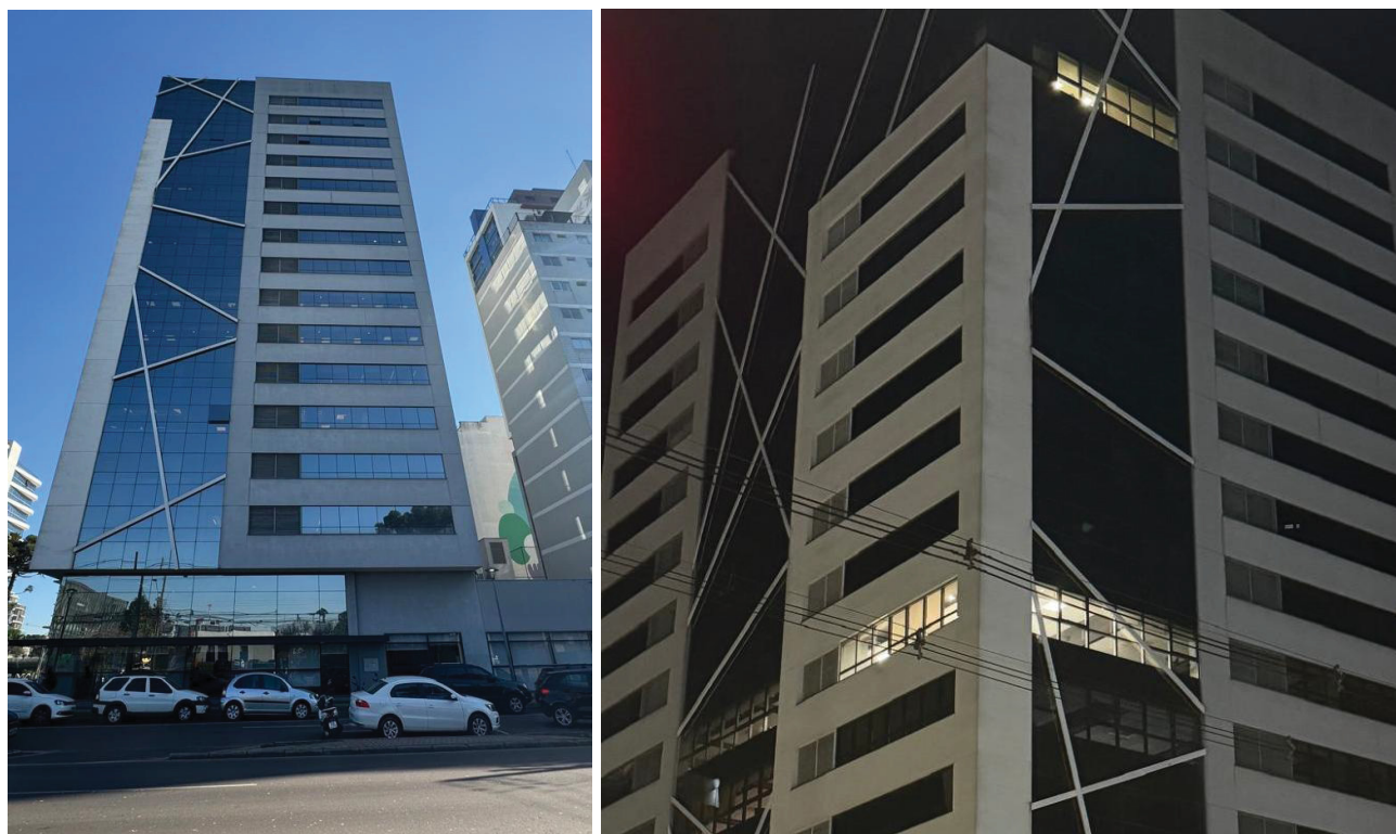
Figura 6 – Iluminação interior de dia e à noite
