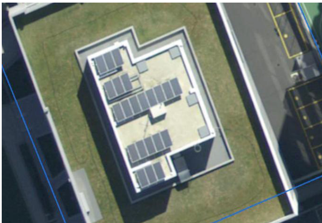
Figura 3 – Imagem aérea do empreendimento A
