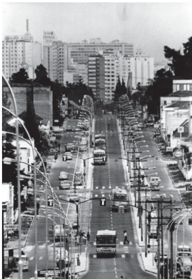
Figura 1 - Modelo trinário, uma via exclusiva para o transporte coletivo ao centro e duas vias de tráfego lento nas laterais
