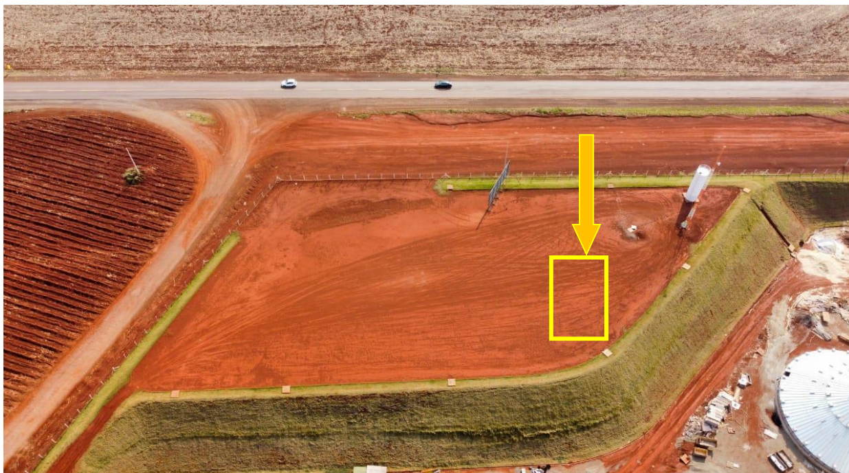
Figura 10 - PONTO DE INSTALAÇÃO DOS PAINÉIS SOLARES
