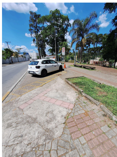
Figura 12 - Irregularidade na calçada
