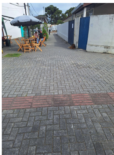
Figura 11 - Trechos incompletos do piso tátil
