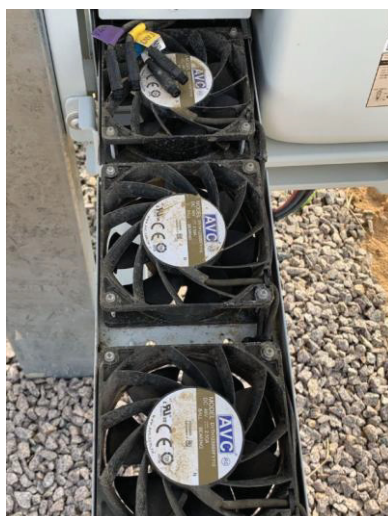
FIGURA 15 – TROCA DE VENTILAÇÃO INTERNA DO INVERSOR
