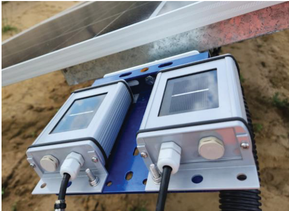
FIGURA 9 – CÉLULAS DE REFERÊNCIA SUJA E LIMPA
