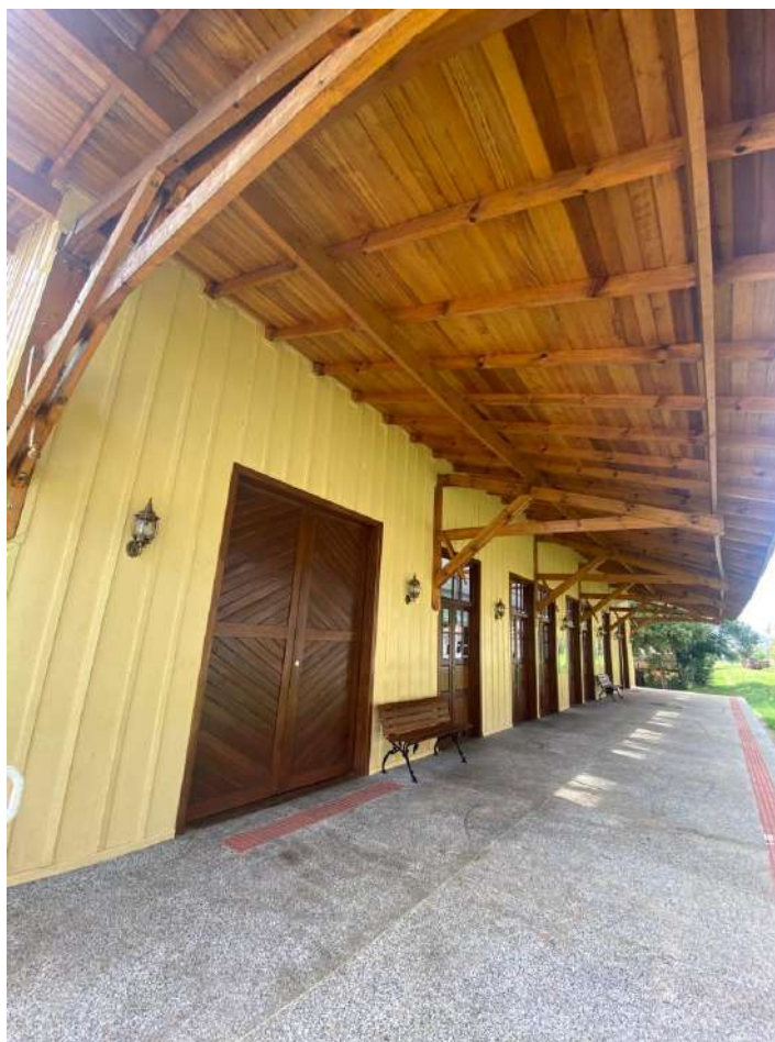
Figura 4 - Plataforma da Estação Ferroviária.
