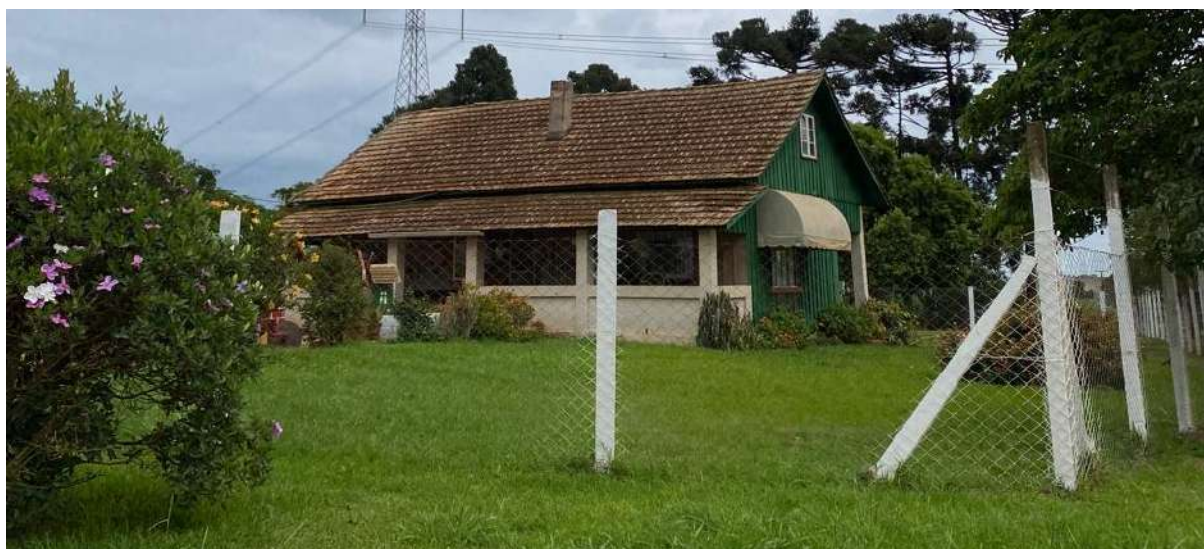
Figura 13 - Fachada da Casa dos Kok.
