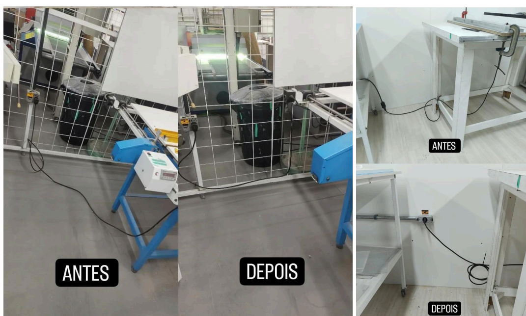
FIGURA 27 - ELIMINAÇÃO DE RISCOS DE ACIDENTE
