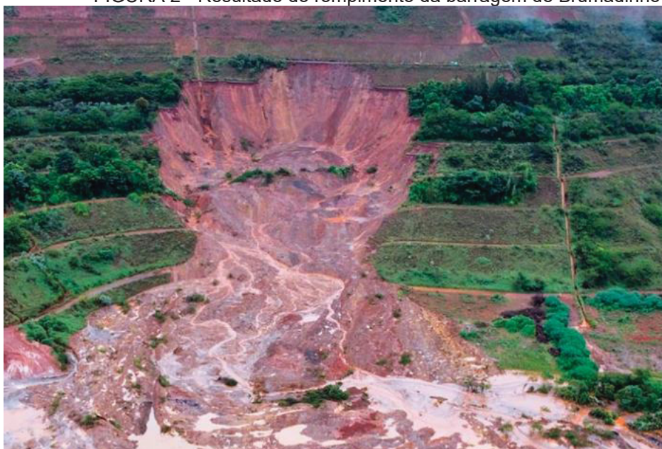
FIGURA 2 - Resultado do rompimento da barragem de Brumadinho
