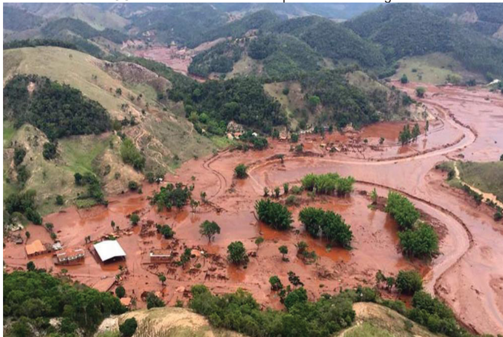
FIGURA 1 – Resultado do rompimento da barragem do Fundão
