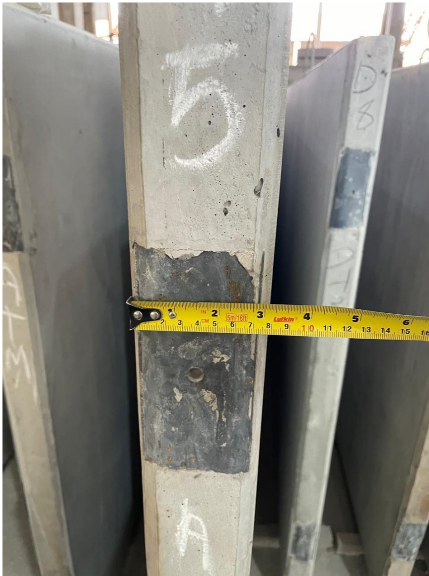
FIGURA 23 - PLACA DE CONCRETO COM CHUMBADOR DE 8CM
