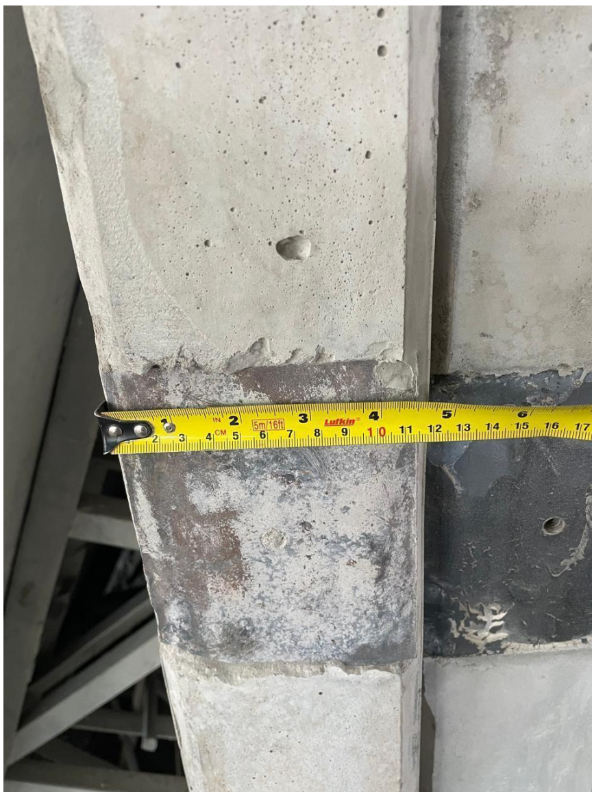
FIGURA 22 - PLACA DE CONCRETO COM CHUMBADOR DE 12CM
