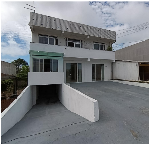
FIGURA 7 - LOCALIZAÇÃO DA FRENTE DO IMÓVEL DO EMPREENDIMENTO
