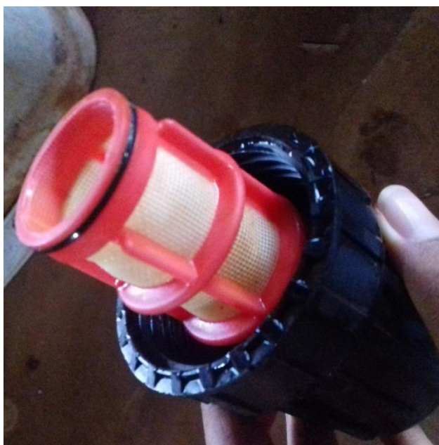
FIGURA 9 – FILTRO APÓS VERIFICAÇÃO DO ENTUPIMENTO.
