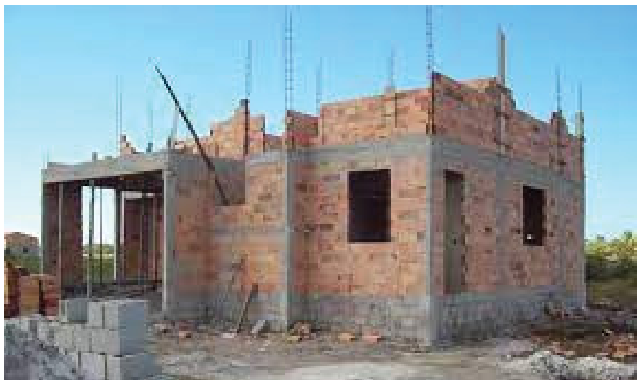
FIGURA 1 – Edificação Convencional ou alvenaria de bloco cerâmico
