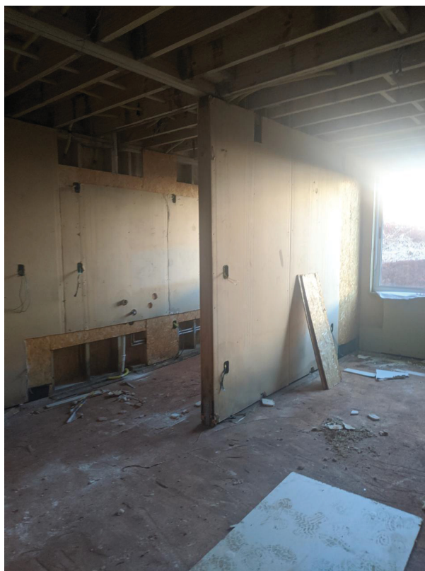
FIGURA 13 – Exemplo da estrutura de um apartamento modelo do objeto de estudo em fase da obra
