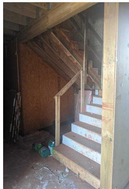
FIGURA 12 – Estrutura em Wood Frame
