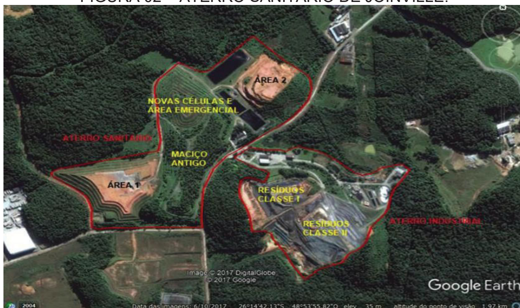
FIGURA 02 – ATERRO SANITÁRIO DE JOINVILLE.
