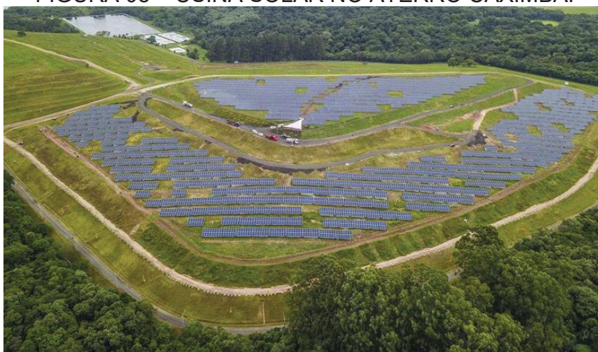
FIGURA 08 – USINA SOLAR NO ATERRO CAXIMBA.
