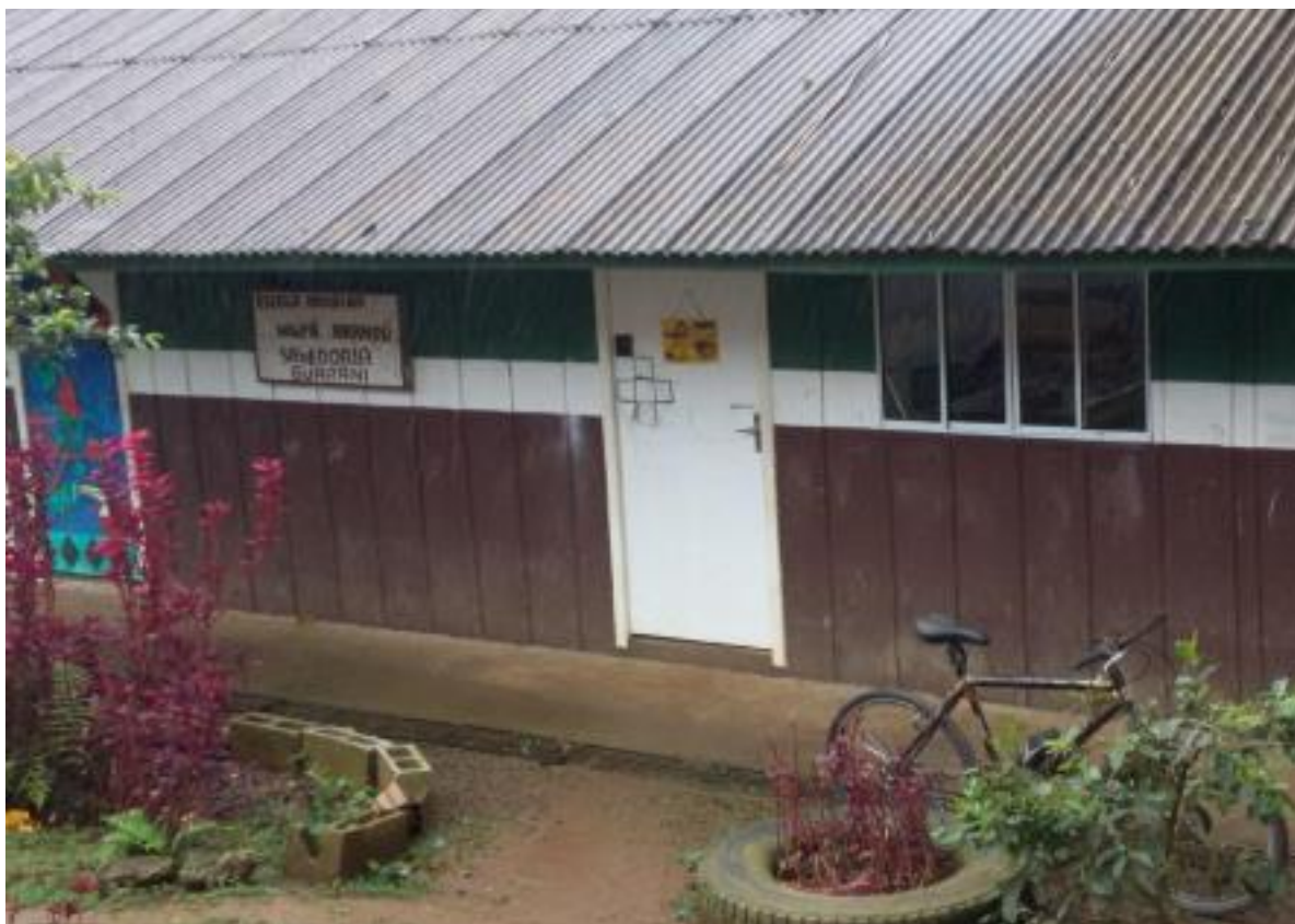
Figura 2 - ESCOLA ESTADUAL INDÍGENA MBYÁ ARANDÚ (Primeira Instalação).
