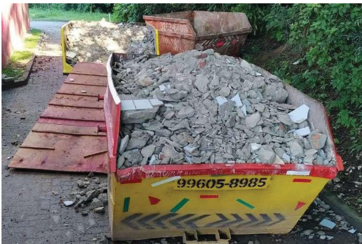
Figura 21 – Caçamba de resíduos da construção civil em uma obra no Centro Politécnico da UFPR
