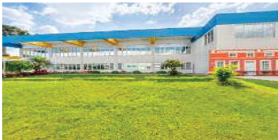
FIGURA 7 – Réplica da Fachada do Colégio Internacional de Curitiba
