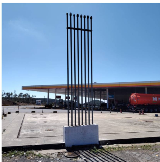
FIGURA 6 - RESPIROS DE TANQUE COM VÁLVULAS DE PRESSÃO E VÁCUO.
