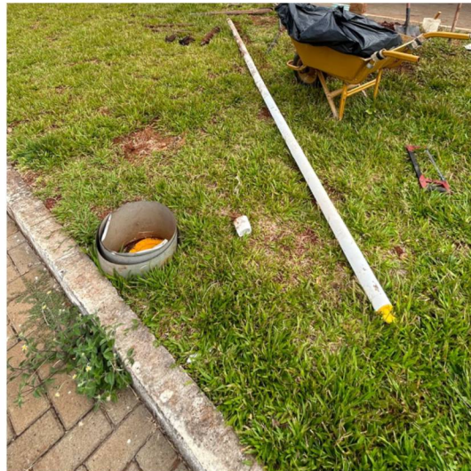
FIGURA 1 - POÇO DE MONITORAMENTO EM CONSTRUÇÃO.
