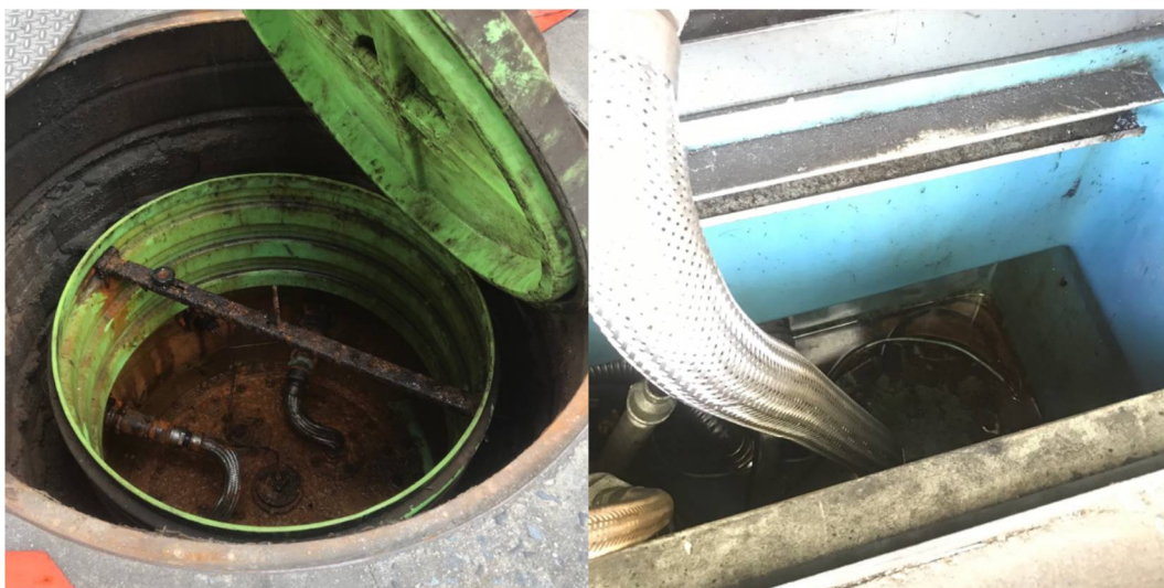
FIGURA 3 - “SUMP” DE TANQUE E DE BOMBA.
