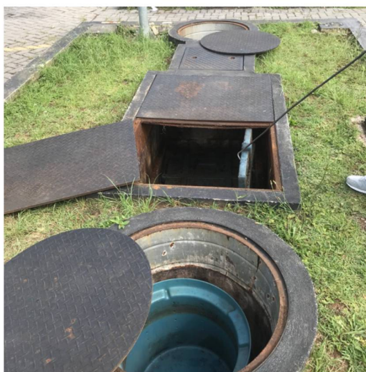
FIGURA 8 - ARRANJO DO SISTEMA DE SEPARAÇÃO ÁGUA E ÓLEO.
