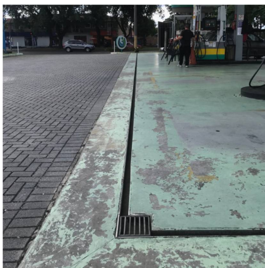
FIGURA 7 - PISO IMPERMEÁVEL E CANALETES DO SISTEMA DE DRENAGEM OLEOSA.
