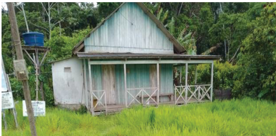
Figura 75 – Sede da Associação de Moradores do PAE Cachoeira. Encontra-se abandonada desde o ano de 2008.
