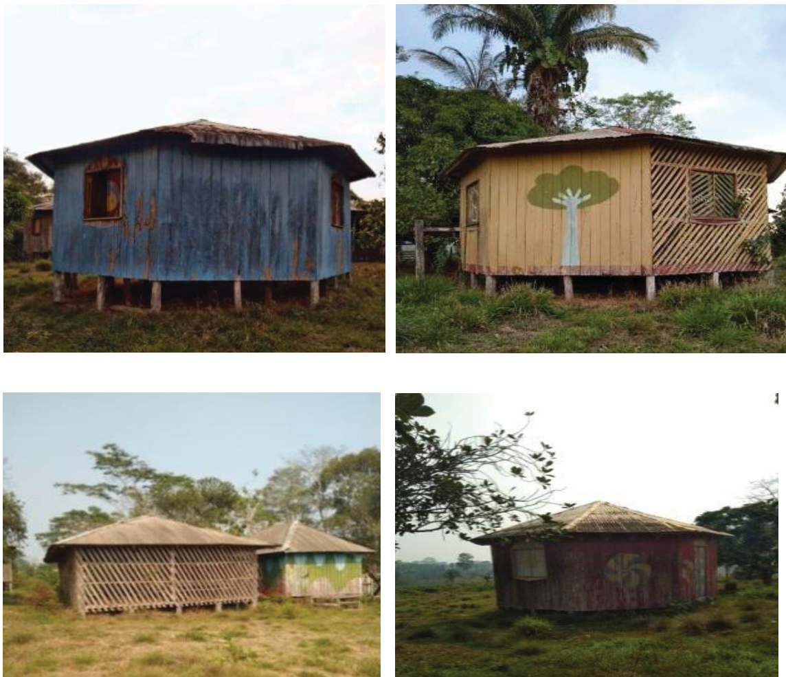
Figuras 93 a 100 – Fotos do centro de treinamento do Sindicato dos Trabalhadores e das Trabalhadoras Rurais de Xapuri. Ele está localizado na colocação Pimenteira. Encontra-se abandonado desde o ano de 2008.
