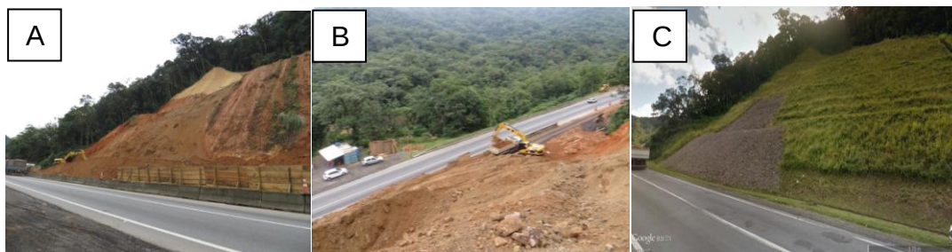
Figura 31: A e B) Fotografias do escorregamento ocorrido em 2014 no km 667 da BR-376, evidenciando a recorrência de escorregamentos neste ponto e as obras de estabilização realizadas. Fonte: (LAGEO, 2014). C) Imagem de maio de 2015, a encosta no km 667 da BR-376 foi novamente retaludada. Fonte: Google Earth, agosto de 2015.
