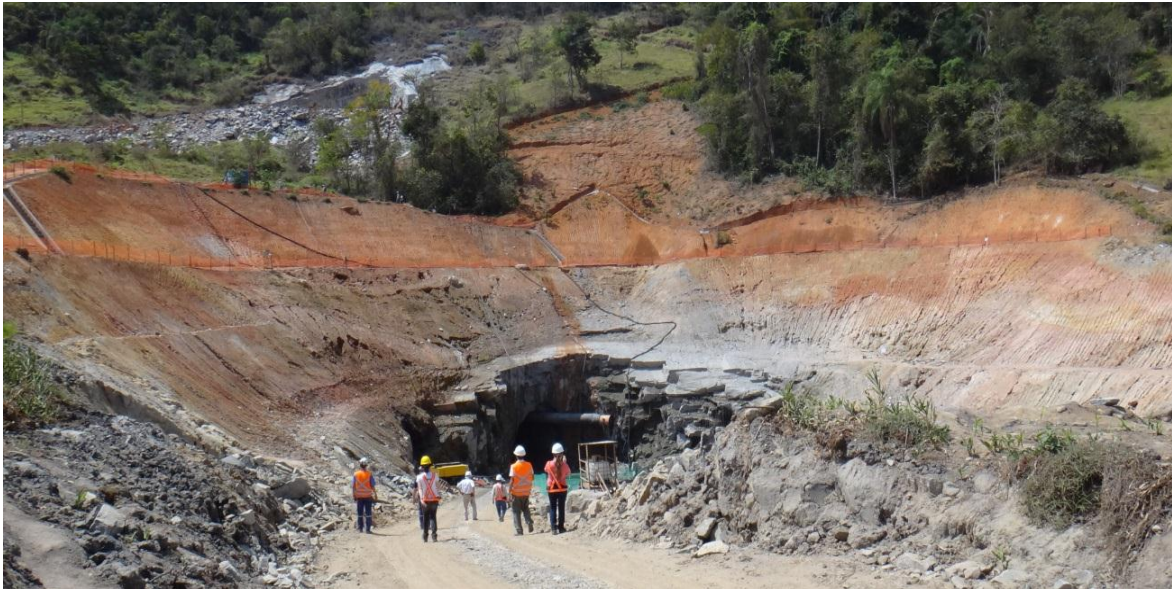
Figura 16: Vista do desemboque do túnel de adução.
