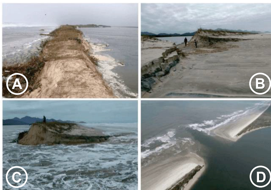
Figura 10: Vista, de sul para norte do esporão arenoso do Ararapira: (A) antes do rompimento, (B) após a primeira passagem das ondas sobre o esporão, (C) no início do rompimento e (D) vista aérea do novo inlet dias após a abertura (Fonte: Adaptado de Souza, 2019).
