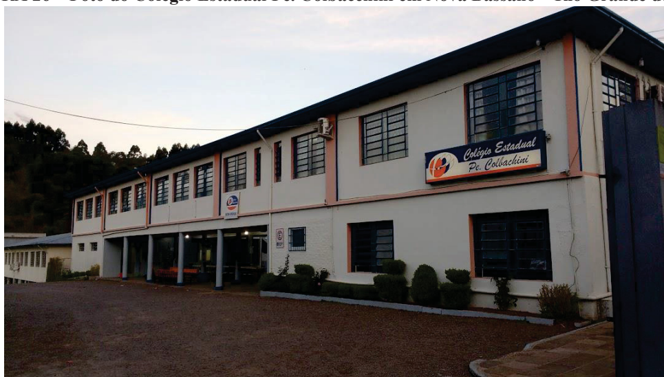
FIGURA 26 – Foto do Colégio Estadual Pe. Colbacchini em Nova Bassano – Rio Grande do Sul 545
