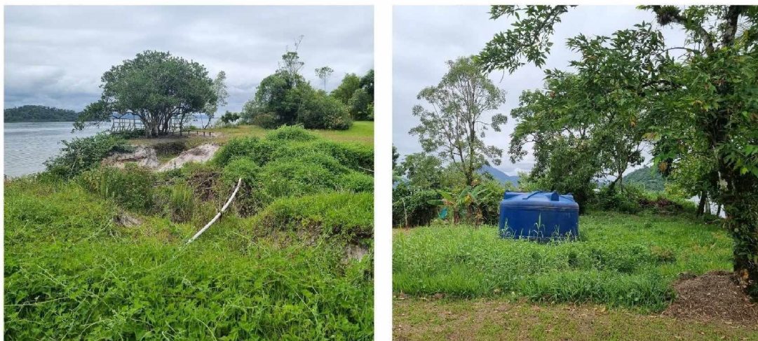
IMAGEM 19 – À ESQUERDA, CANO DE ÁGUA EXPOSTO, À DIREITA, CAIXA D'ÁGUA NÃO INSTALADA
