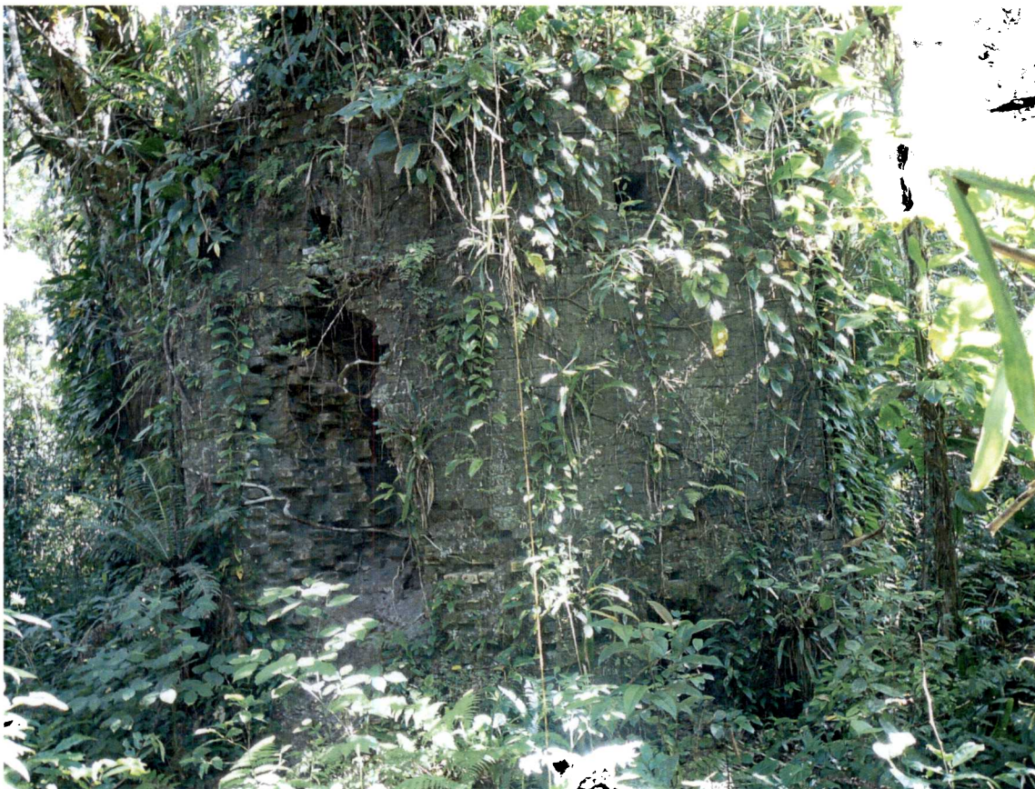
FIGURA 4 - FORNO DE CAIEIRAS FONTE: O autor (2008)
