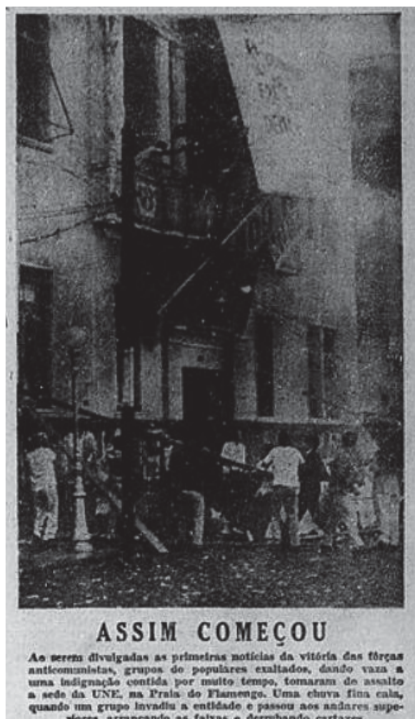
FIGURA 4: incêndio na UNE
