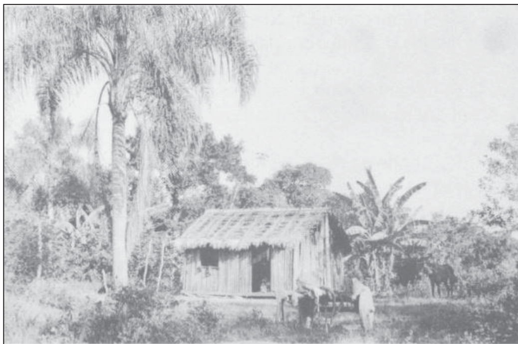
FIGURA 12 - CASA PAU-A-PIQUE DE CABOCLOS EM MATINHOS
