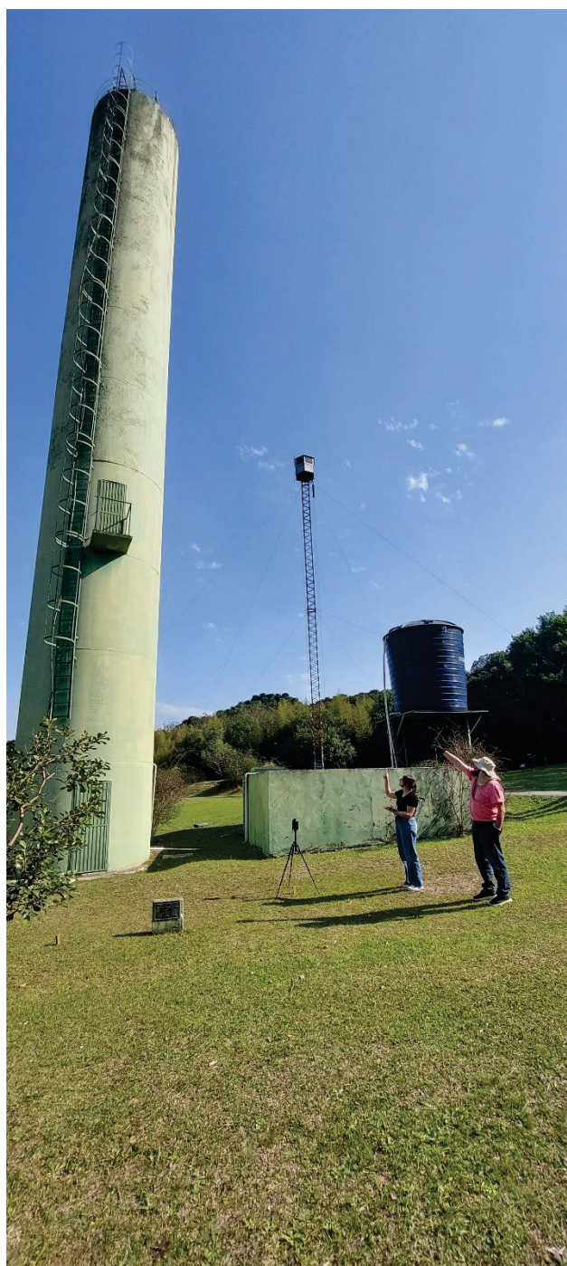
Figura 18 - Reservatório de água do Bloco da Engenharia Florestal
