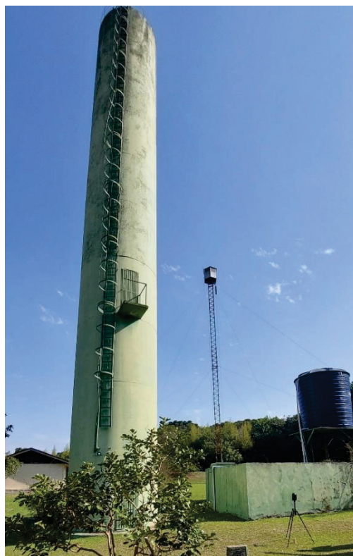
Figura 41 - Vista do reservatório de água e a varredura à laser em uma estação
