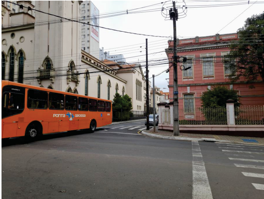
Figura 24 – Fachada de esquina do Colégio Regente Feijó
