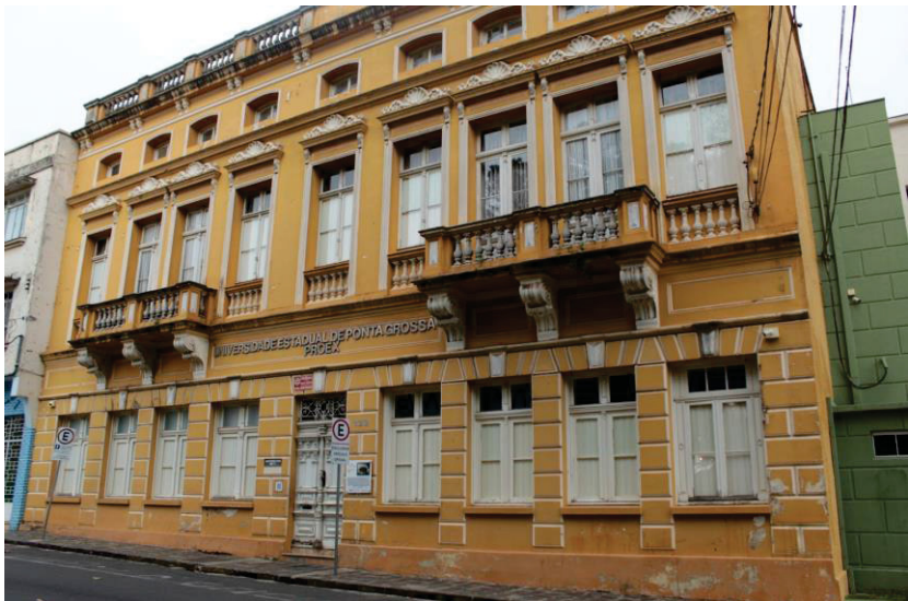
Figura 28 – Fachada do Edifício Guilherme Neumann
