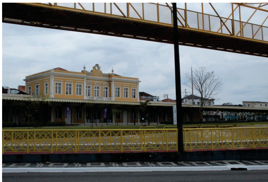
Figura 22 – Fachada principal da Estação Saudade
