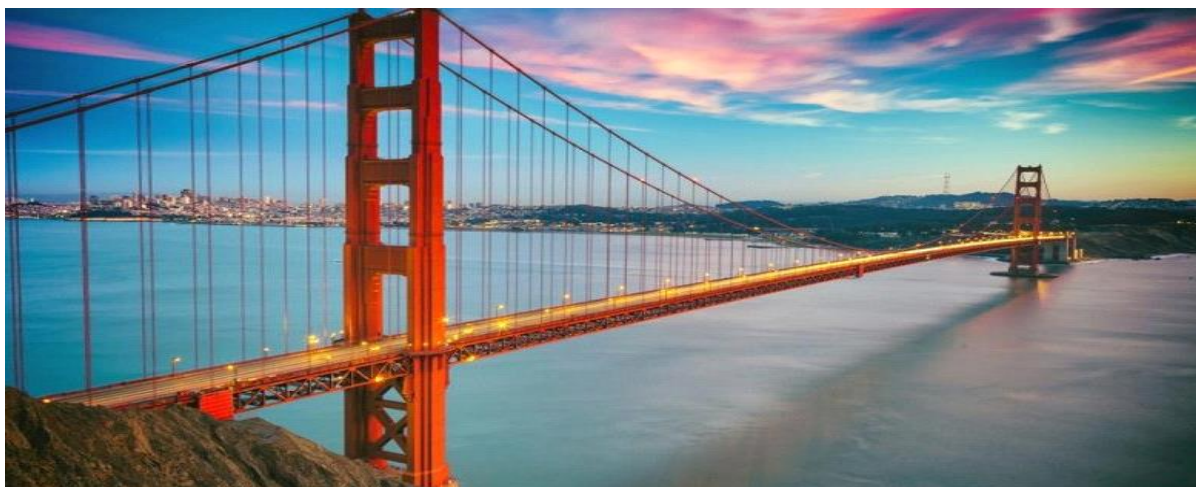
FIGURA 6 – PONTE GOLDEN GATE
