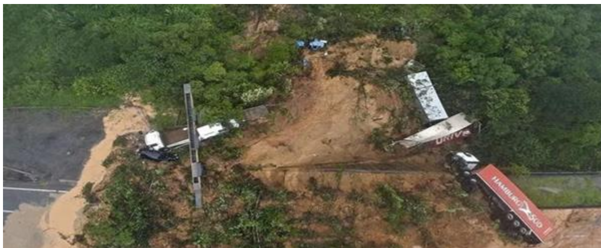
FIGURA 1 – DESLIZAMENTO BR-376 EM 28/11/2022
