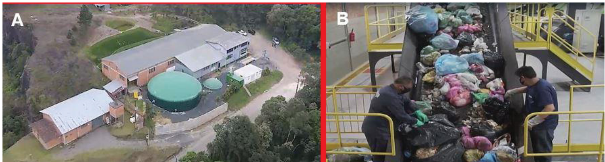
FIGURA 4 - (A) BIODIGESTOR ORIENTADO A LA GENERACIÓN ELECTRICA Y CALOR, (B) EL COPRODUCTO RSU (RESIDUOS URBANOS SOLIDOS) ES LA BIOMASA UTILIZADA PARA LA GENERACIÓN DE METANO
