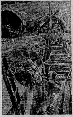
A conclusão deste viaduto — Augusto Frederico Schmidt — vai permitir o tráfego ininterrupto nas duas pistas do túnel Rebouças sem congestionamentos.
