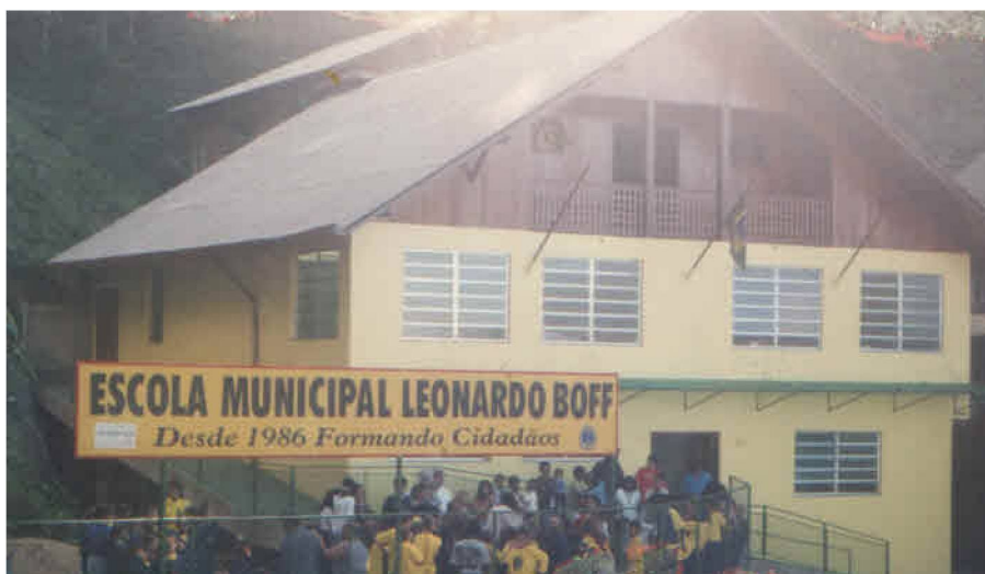
Fotografia após conclusão das obras em 2002
