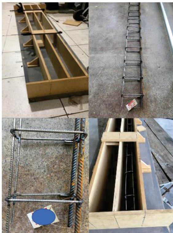
Figura 4.2.1 – Processo de montagem da caixaria e ferragem da viga
