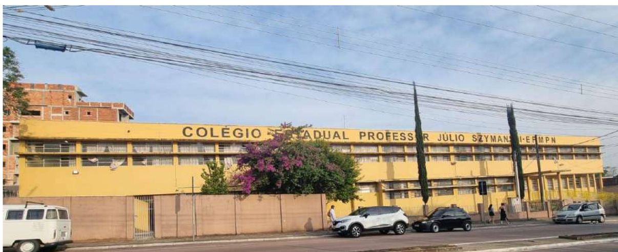
FIGURA 2 - FACHADA DO COLÉGIO JÚLIO SZYMANSKI
