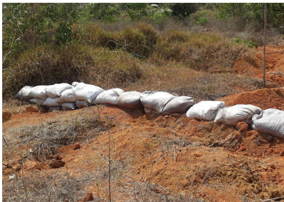
FIGURA 8. COMBATE À EROSÃO COM COMPOSTO ORGÂNICO EM SACAS DE RÁFIA.
