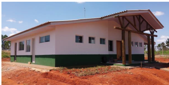
FIGURA 4 - Estrutura administrativa e recepção
