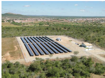
FIGURA 2 – USINA SOLAR DE TAUÁ
