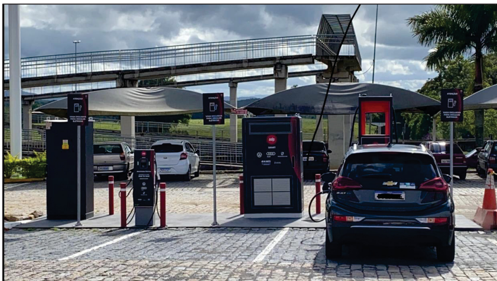
FIGURA 5: CENTRO DE RECARGA PARA VEÍCULOS ELÉTRICOS, COM DUAS ESTAÇÕES DE RECARGA E QUATRO PONTOS DE RECARGA
