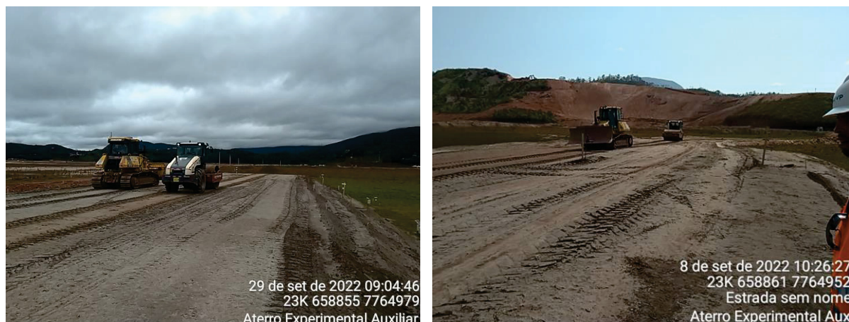
FIGURA 3.22 – ROLO LISO A/V + TRATOR DE ESTEIRAS – EXEMPLOS DE TESTES EM COMBINAÇÃO.
