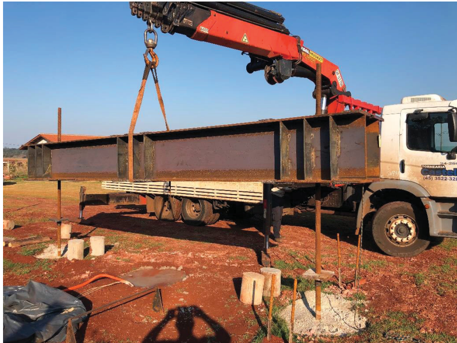
FIGURA 65 – DETALHE DA MONTAGEM DA VIGA COM ENRIJECEDORES
