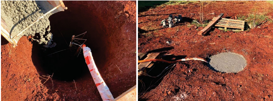
FIGURA 54 – CONCRETAGEM DOS TUBULÕES
