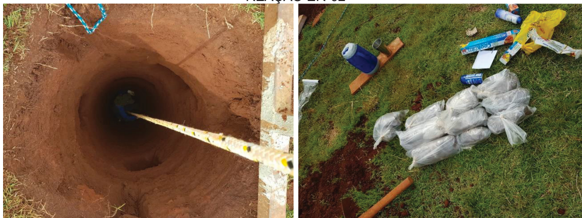
FIGURA 47 - DETALHE DA EXTRAÇÃO DAS AMOSTRAS INDEFORMADAS DA ESTACA DE REAÇÃO ER-02
