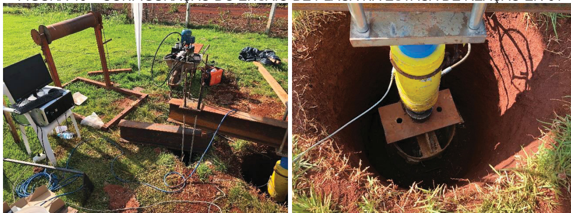
FIGURA 46 – CONFIGURAÇÃO DO ENSAIO DE PLACA NA ESTACA DE REAÇÃO ER-01
