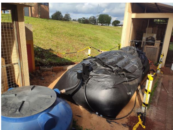
FIGURA 6 – BIODIGESTOR INSTALADO
