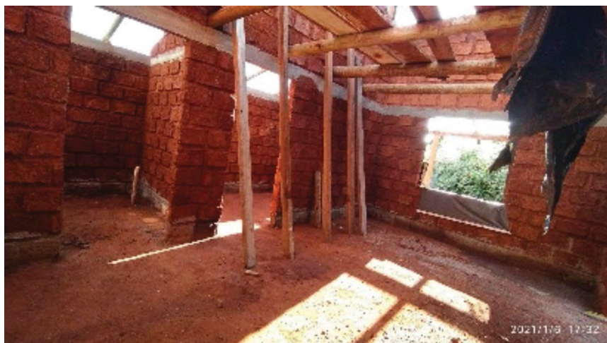
FIGURA 17 - VISTA INTERNA DURANTE A CONSTRUÇÃO DO CASO 1 - CASA
