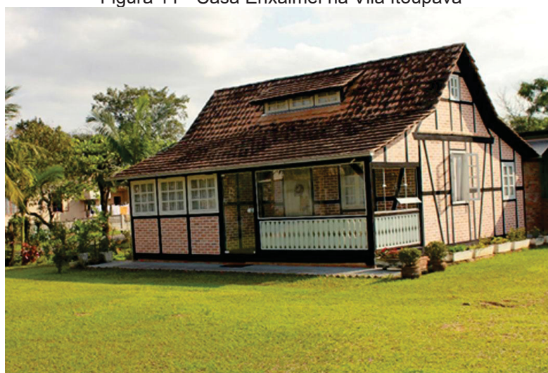
Figura 11 - Casa Enxaimel na Vila Itoupava
