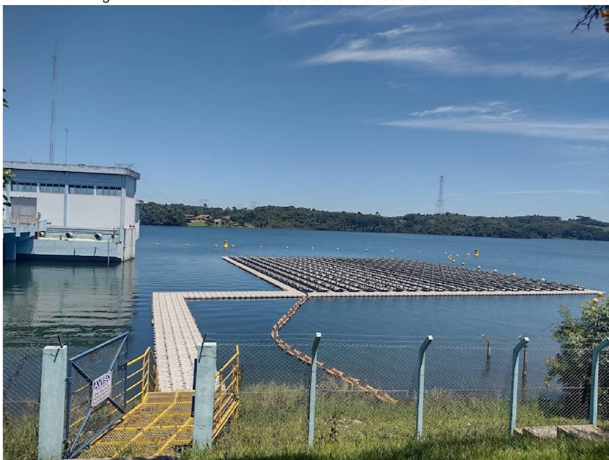
Figura 2 – Sistema fotovoltaico flutuante no reservatório Passaúna.
