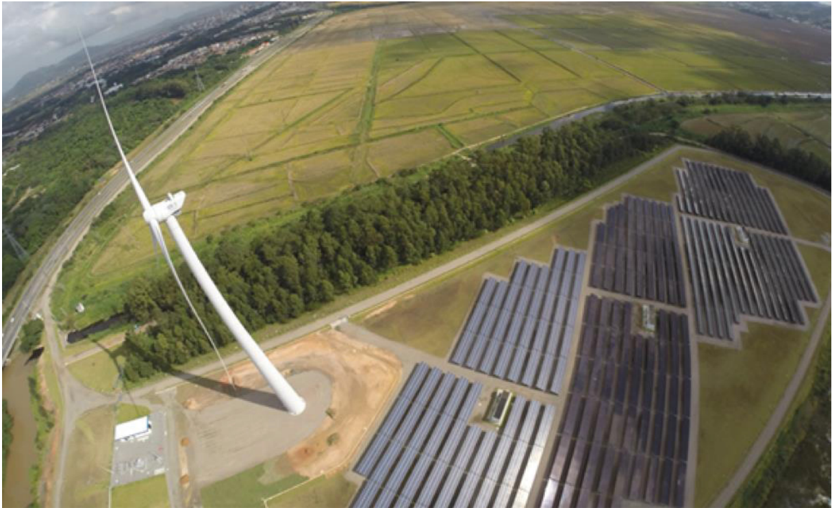
FIGURA 2 - USINA HÍBRIDA DE ENERGIA SOLAR FOTOVOLTAICA E EÓLICA
