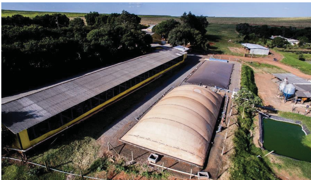
FIGURA 1 - BIODIGESTOR MODELO LAGOA COBERTA APLICADO NO TRATAMENTO DE EFLUENTES DA SUINOCULTURA
