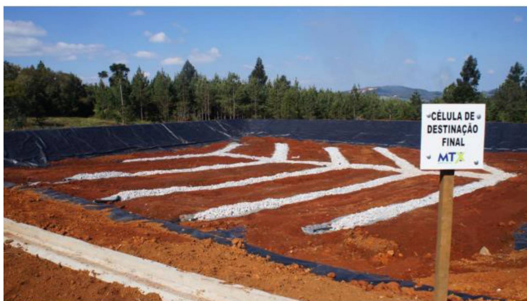
FIGURA 9 – SISTEMA DE DRENAGEM DE LIXIVIADOS
