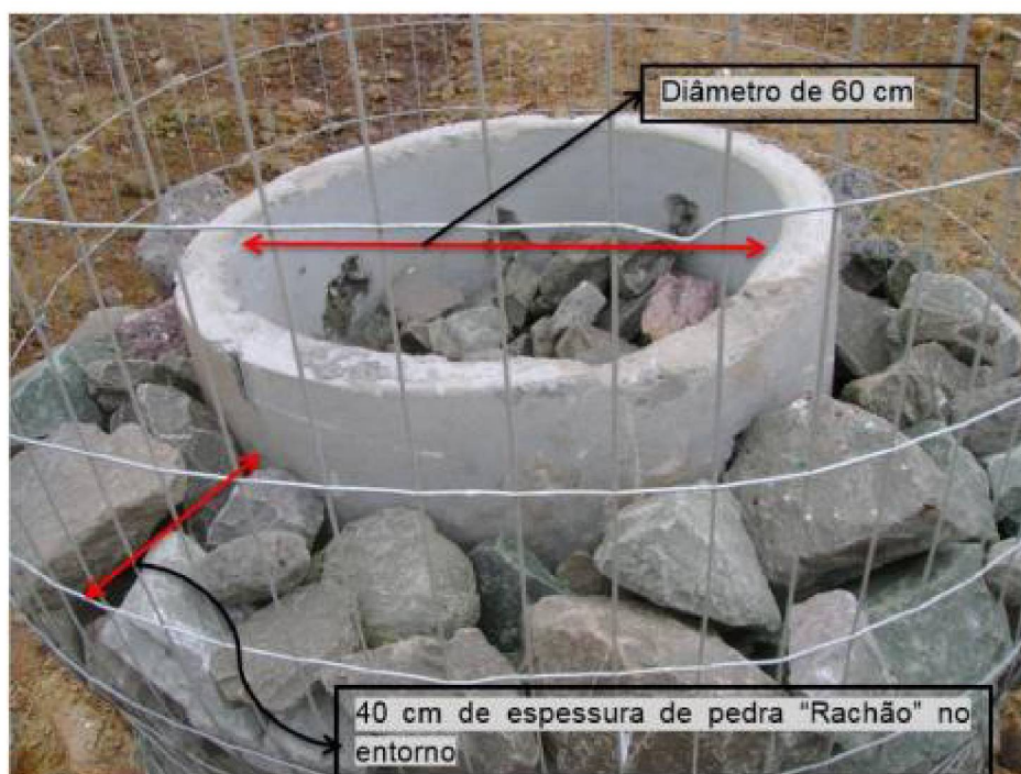
FIGURA 11 – DRENO DE GASES DE ATERRO
