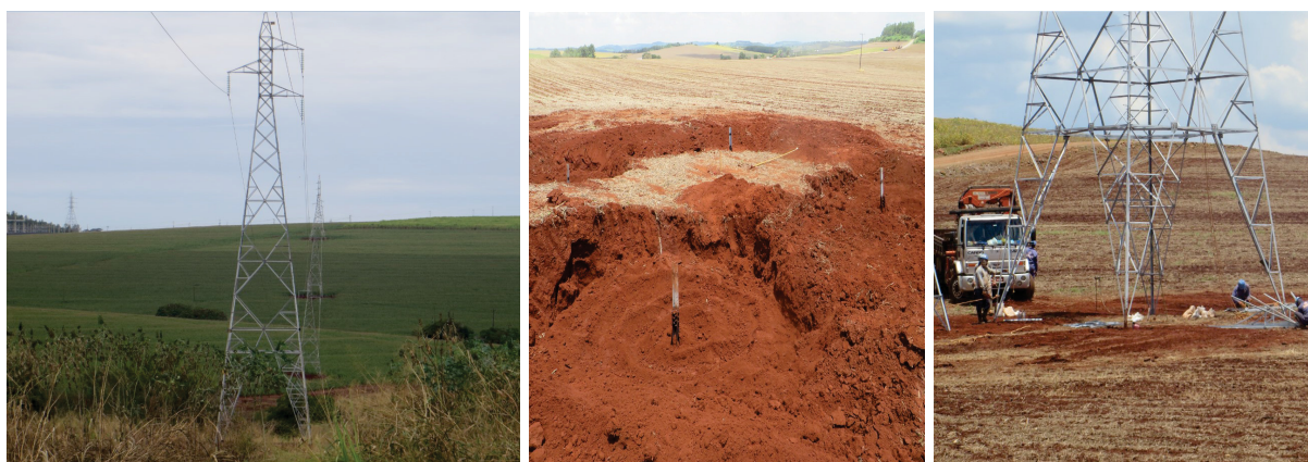
FIGURA 2 - PARTE DO TRAÇADO DA LDAT 138 kV MANDAGUARI-SÃO PEDRO DO IVAÍ E ATIVIDADES DE CONSTRUÇÃO DA MESMA
